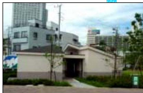
東京白鷺都営住宅 (地下型WFFフィルター)
