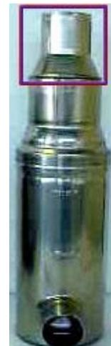
丸樋60mmの竖樋を切断、GSフィルターを設置後、小規模タンク天水尊と接続した事例
