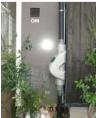
左の写真は、「地下埋設で、雨水利用をしているが、ゴミがたまってしかたがない」という相談を受け、ライナスを導入した事例です。雨水利用をしていながら、まともなフィルター装置がないという事例が多くあります。ライナスであれば、「後」からでも手が打つことができます。
