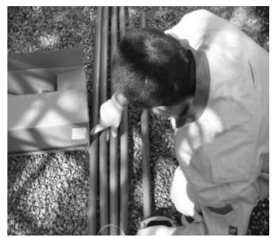
塩ビ管を用意します。 塩ビ管は、底から30cm程度 上になるようにします。底に近 すぎると、埋没してしまうなど の問題があります。
