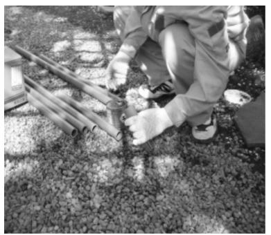
塩ビ配管は2mもしくは1mごとに配管していきます。2mでは天井にぶつかる場合などは、1mごとにします。通常の塩ビ管の販売単位は4mです。ソケットを用意し、あらかじめ接着しておきます。
