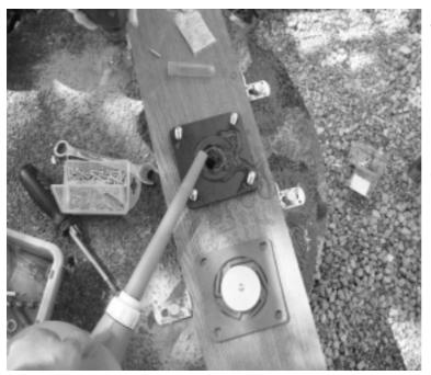
配管に水を満たします。弊社は先端にフート弁をつけているので、水は落ちません。 6 mの配管でもジョウロ 1 杯分で水をみたすことができます。
